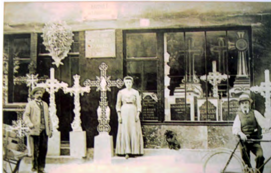
Entreprise BRICHET-BAUDRILLER, marbrier, rue Sainte-Gemmes à Évron (Mayenne) vers 1910
